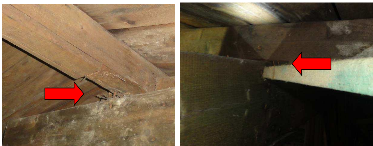
Obr. 5 a 6: Vybrané chyby hřebíkových spojů
