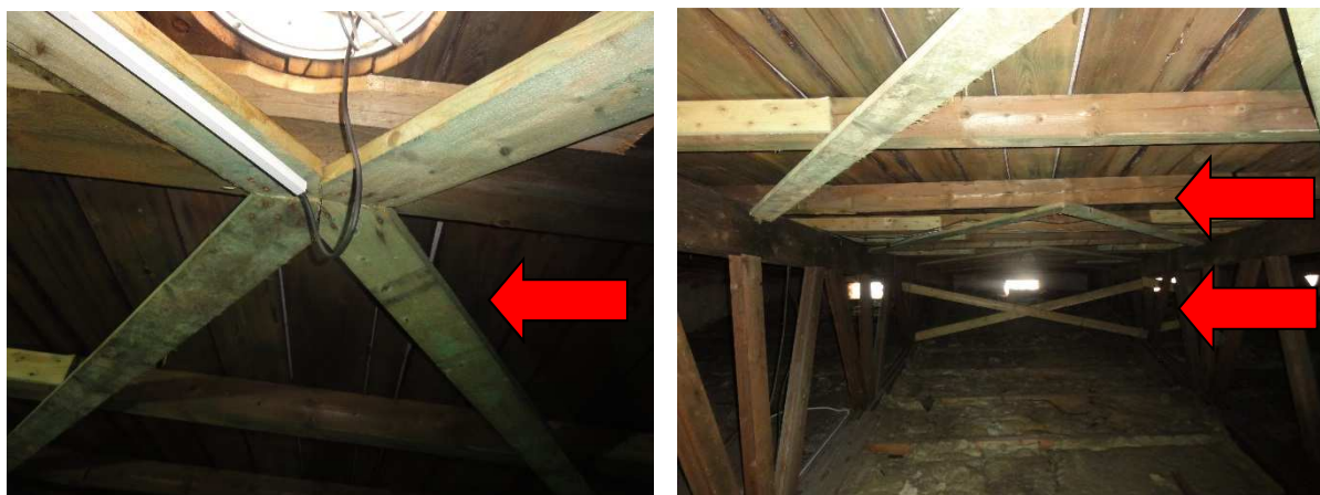
Obr. 9 a 10: Dodatečné ztužení vazníkové střešní konstrukce
